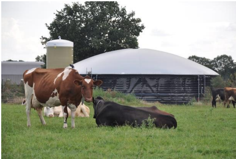
Figuur 4-8: Foto van de mestvergistingsinstallatie Biogas-Hub Oxe (Deventer)
